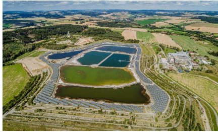
Fotovoltaická elektrárna Rožná
